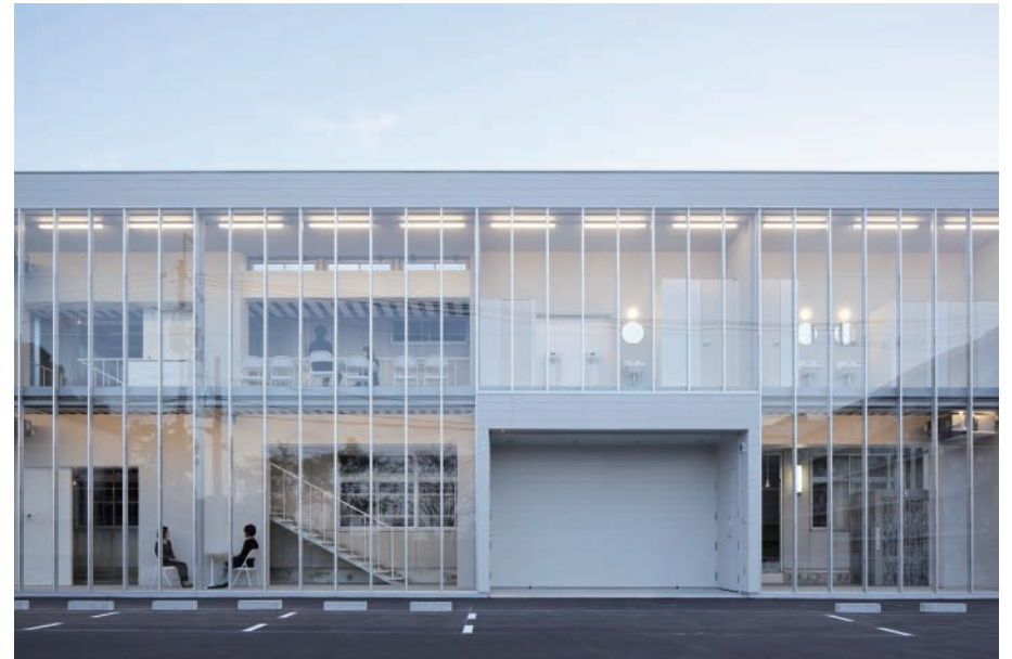
中川政七商店旧社屋増築棟(奈良、2012年)
